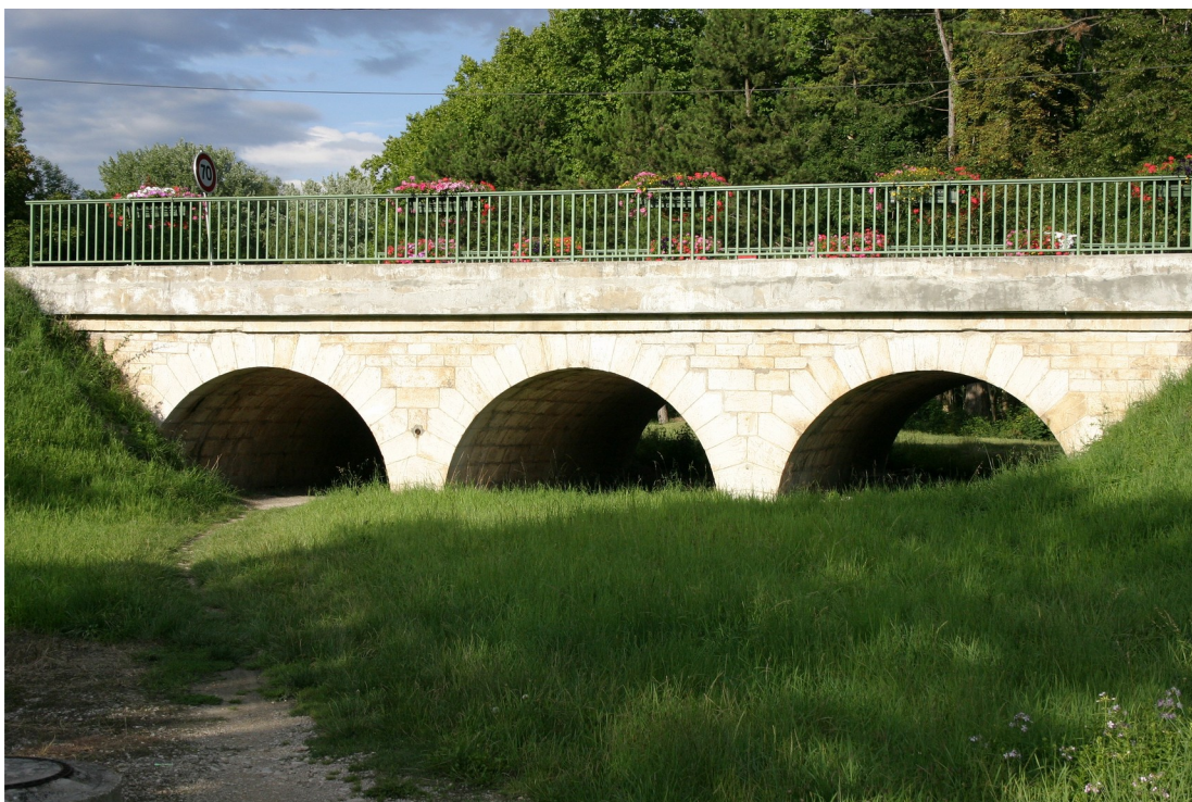
Ouvrage de décharge de la brèche nord
