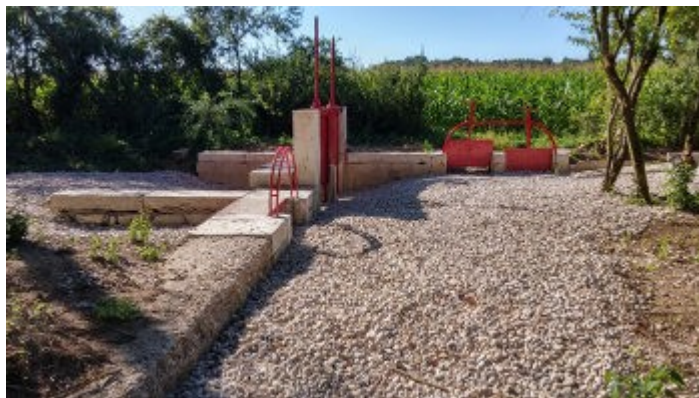
À l'aval et à l'amont du barrage
