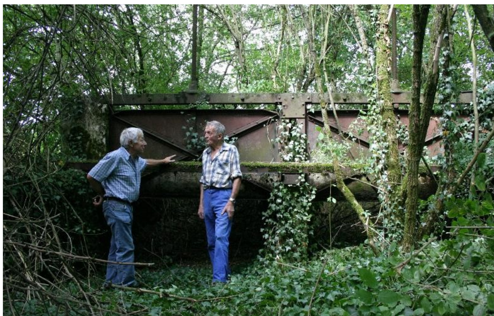
Les Vannes Rouges construites à la fin du XIX e siècle
