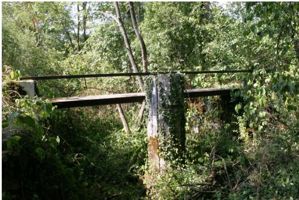
Dispositif ayant remplacé l'empellement N°2
