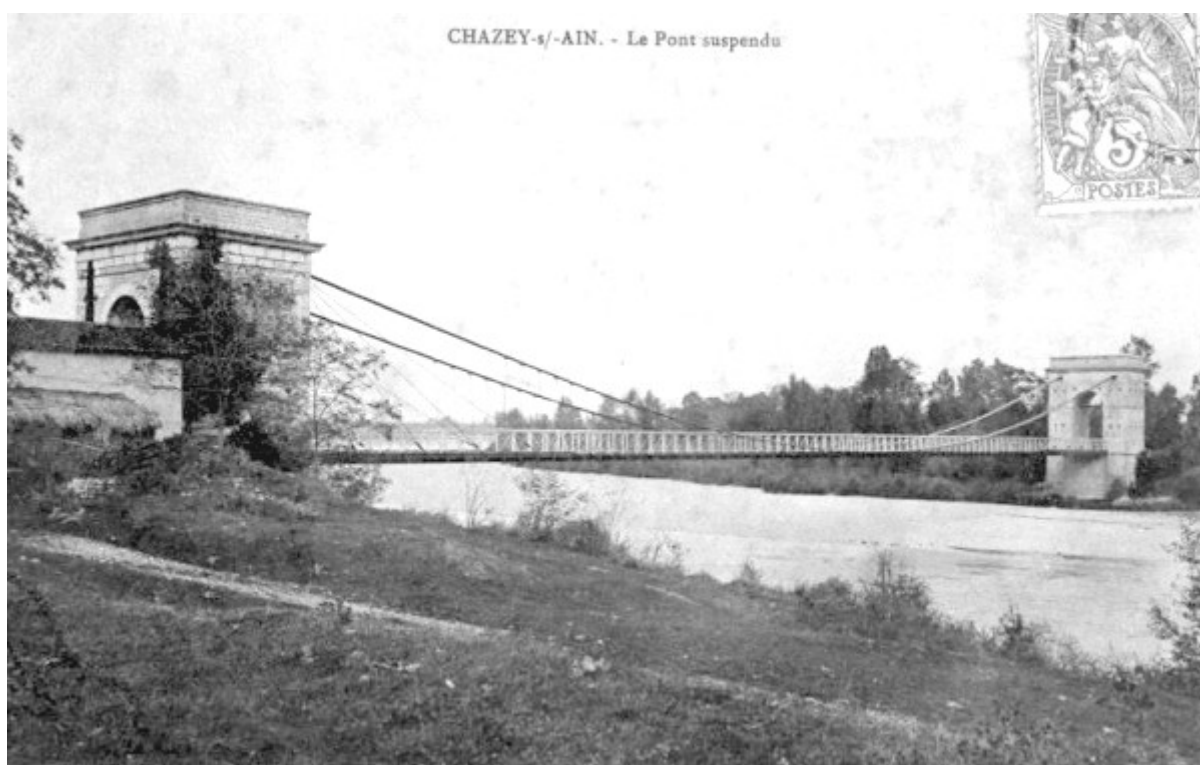
Le pont de Chazey est remplacé en 1829 par un pont suspendu étroit en fil de fer, construit par M. Seguin, le spécialiste de ce genre d'ouvrages. On ne connaît encore pas les câbles torsadés en acier. Ce pont a été dynamité en 1944, reconstruit en 1957, puis en 1977, toujours pour cause d'instabilité du lit de la rivière.
