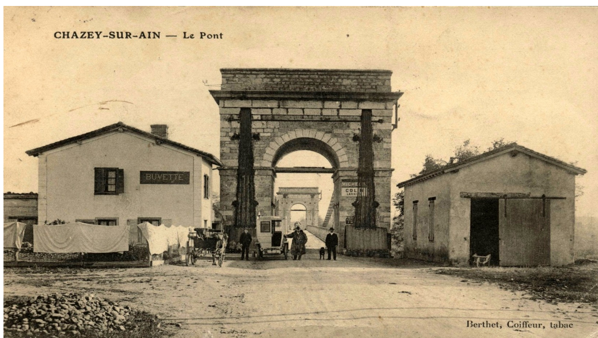
La culée ouest avec ses amarres et l'atelier d'entretien – Collection J. Grimbot
